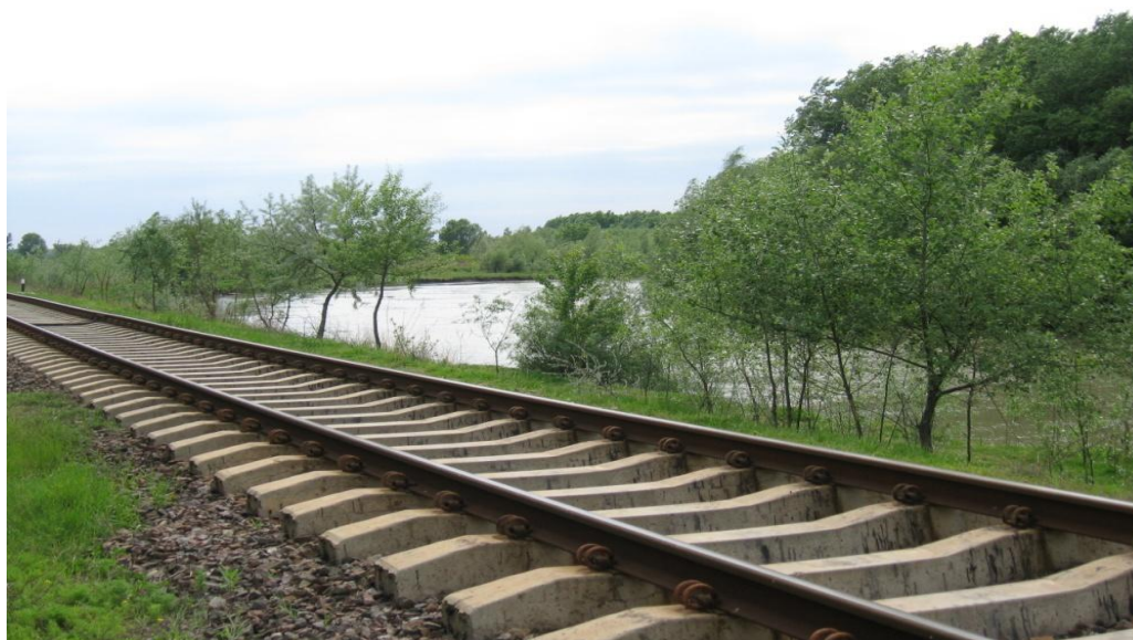
Figura. 26. Calea ferată ce traversează ZUII „Lacurile Prutului de Jos”.
